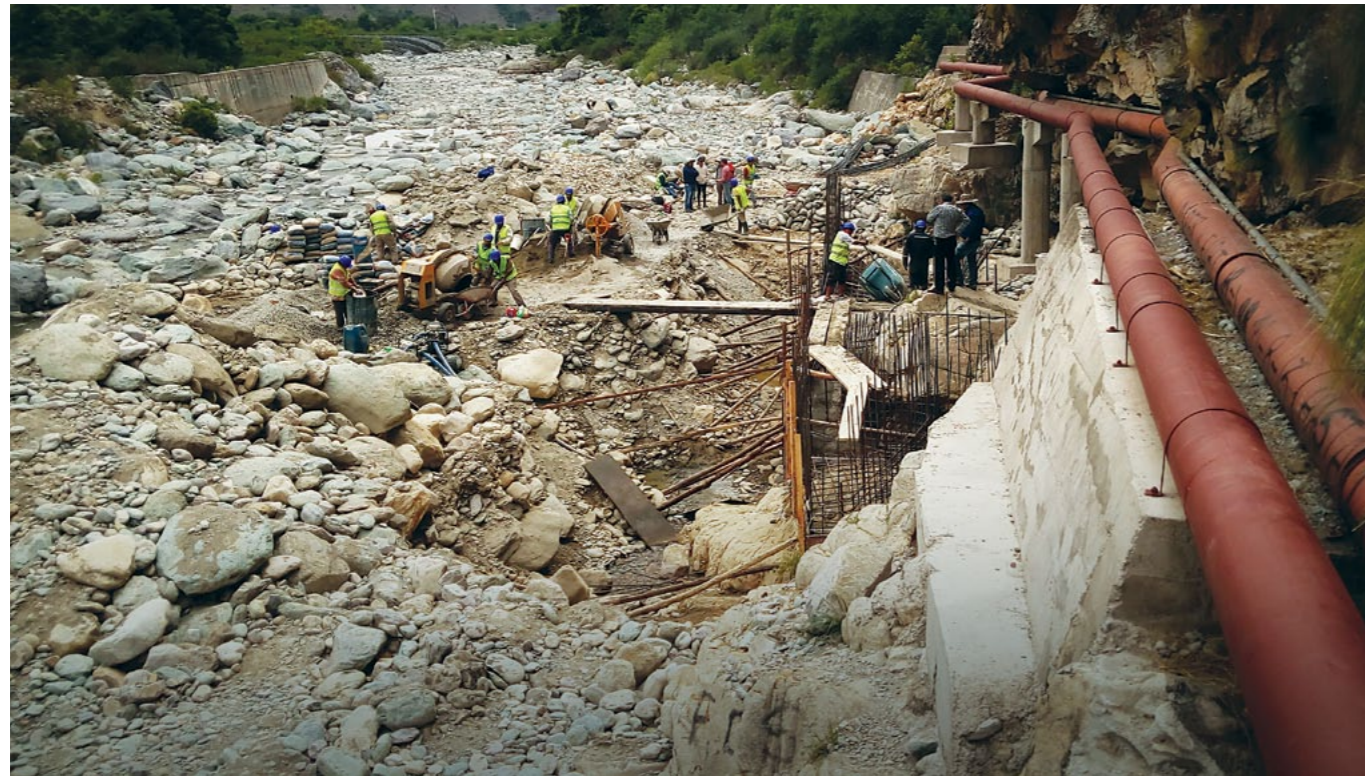
Foto. Construcción de defensivo de hormigón armado que protege de las crecidas del Río Sola a las tuberías que alimentan el sistema de riego Bella Vista
