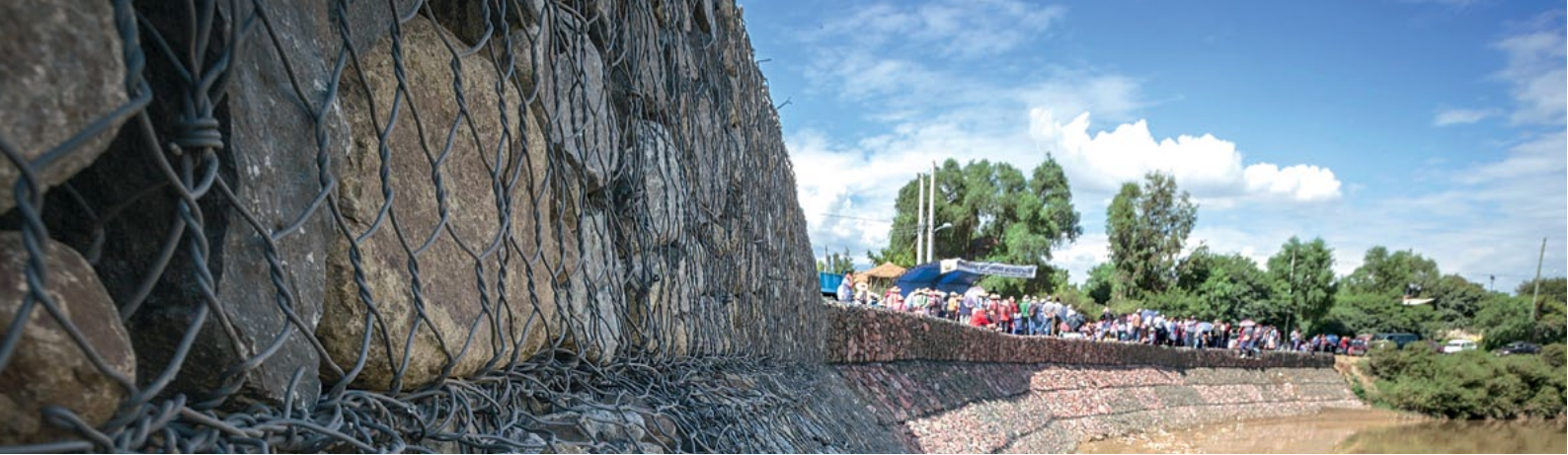
Fotografía: Muro de gaviones resiliente - Vinto, Cochabamba
